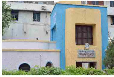
Pa y & Use Toilet
